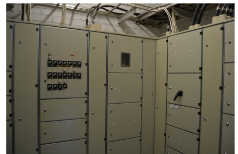
Sähköpääkeskuksen laitteisto
